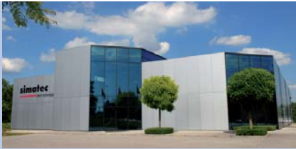
simatec ag, Wangen a. Aare, Switzerland
